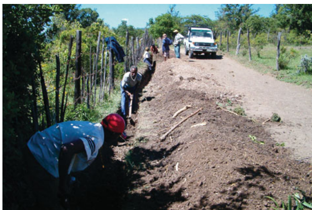
Gli abitanti locali scavano per permettere la posa di tubature, in Kenia.
