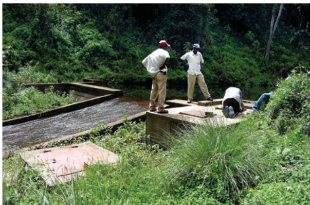
Acquedotto per il Mutitu Water Project, in Kenia.
