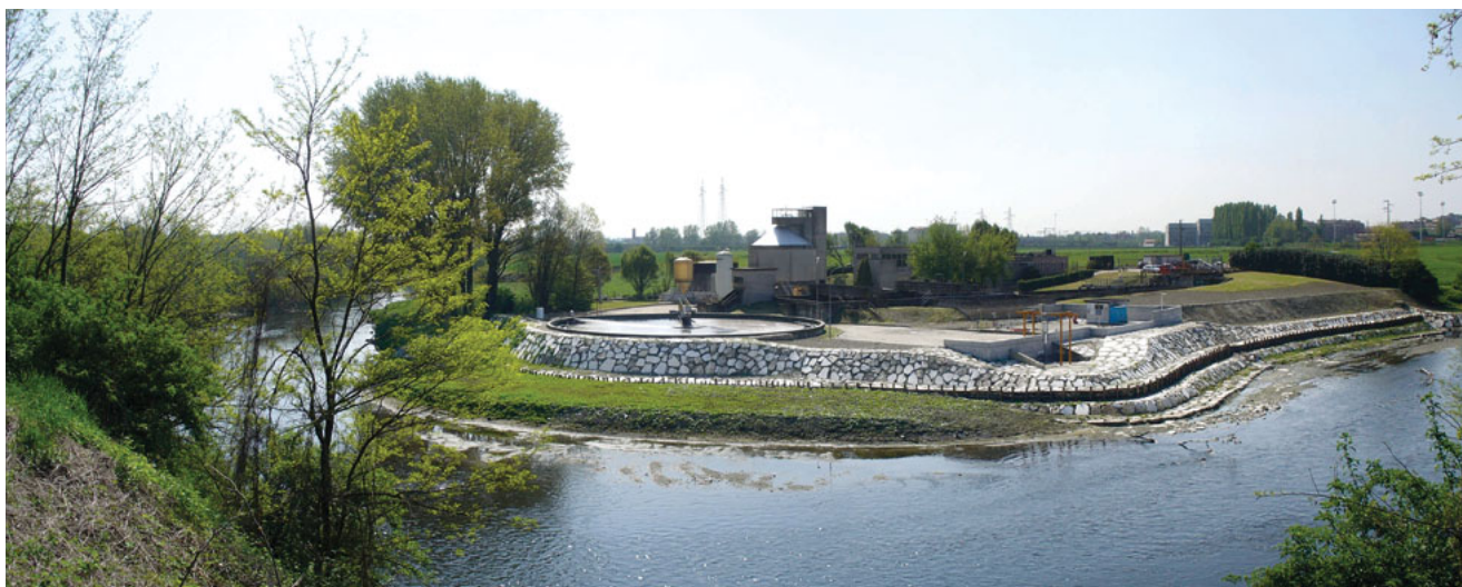
Fiume Lambro Settentrionale – Depuratore acque reflue di Melegnano
